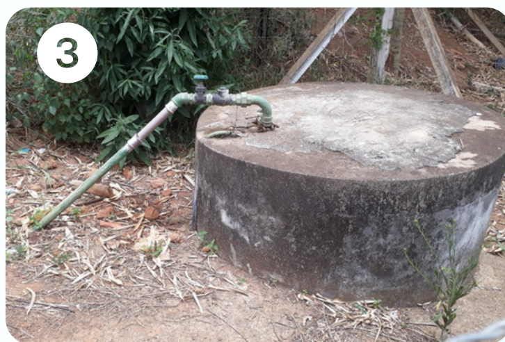
FOTO 2 E 3 - ABASTECIMENTO VIA CAMINHÃO PIPA EM CAIXA D'ÁGUA OU CISTERNA
